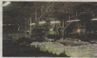
Interiör från Gamla bruket från 2007 då byggnaden fortfarande användes som lager. Fackverkskonstruktionen av stål syns.
